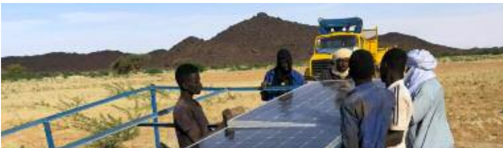
ACHAT ET POSE DES Panneaux SOLAIRES POUR QUE LA POMPE PUISSE REMONTER L'EAU
