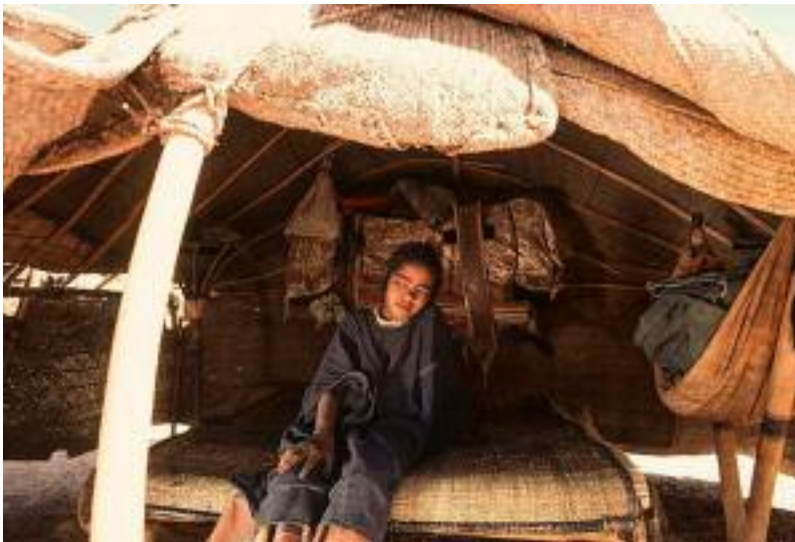
L'habitat traditionnel qui compose le village est en fibres de palmier tressées sur une structure légère en bois.
